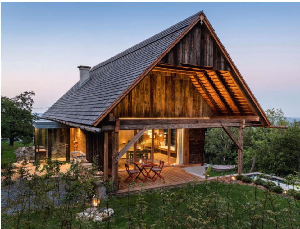
Die wiedererrichtete, zum Ferienhaus umgebaute Scheune erhielt einen verglasten Windfang und eine Fensterfront.
